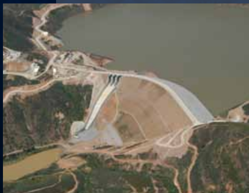
Construção da Barragem de Odelouca – Silves, Portugal
