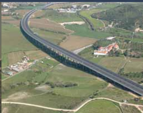
Construção do Viaduto de Vale Flores – Carregado, Portugal
