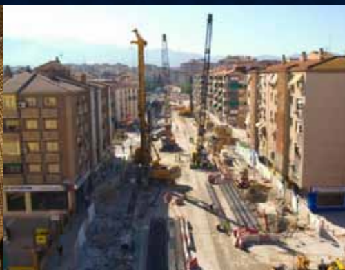
Execução de estacas de 950 mm para as cortinas de contenção do canal do Metro de Granada – Granada, Espanha
