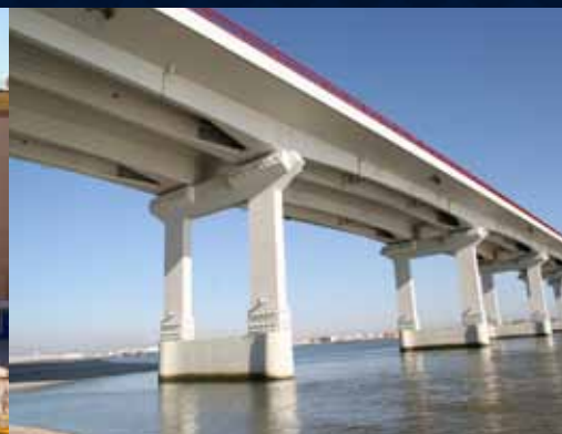
Reabilitação da Ponte da Barra sobre o Canal de Mira – Aveiro, Portugal
