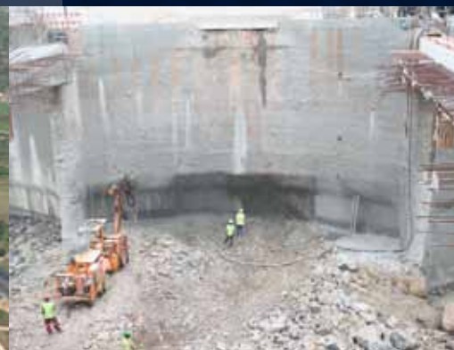
Trabalhos de Estacas e Betão Projetado, integrados na Concepção e Construção dos Toscos do Prolongamento da Linha Azul – Amadora, Portugal
