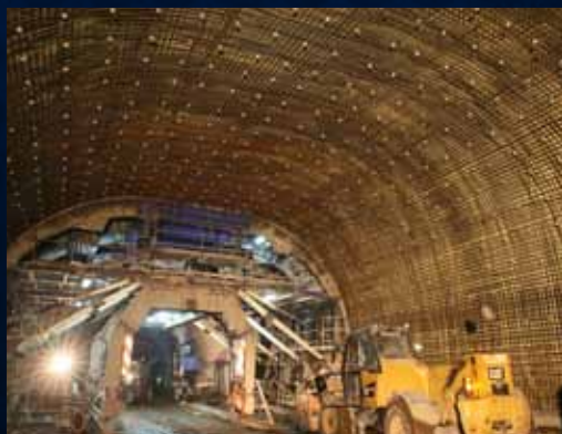
Construção da Via Expressa Ribeira de S. Jorge – Arco de S. Jorge – Madeira, Portugal
